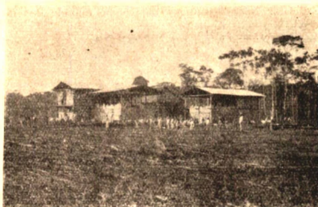
Edificios construidos en Putumayo para Cuartel
