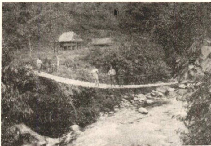
Napo. — Puente sobre el río Jondach
