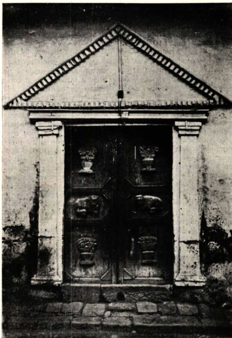
Portada de un edificio ambateño del siglo pasado, que nos recuerda las construcciones de la época colonial.
